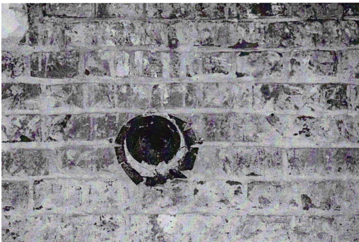
Видовая точка № 26 Вентиляционный продух в помещениях 2-го этажа (Яблонская М.А., 27.09.2019)
