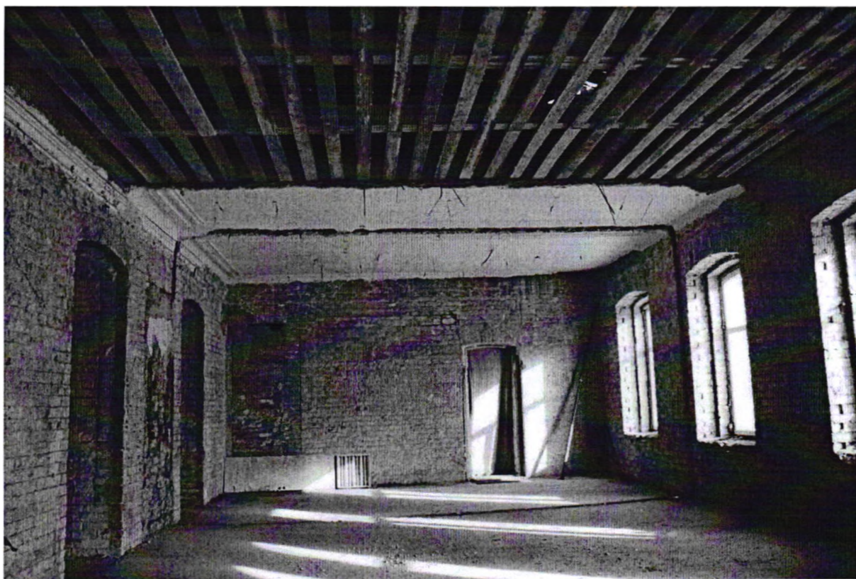
Видовая точка № 21 Общий вид помещения 2-го этажа (Яблонская М.А., 27.09.2019)
