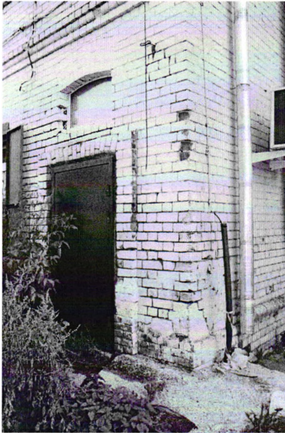
Видовая точка № 16 Фрагмент западного фасада. Дворовый вход
