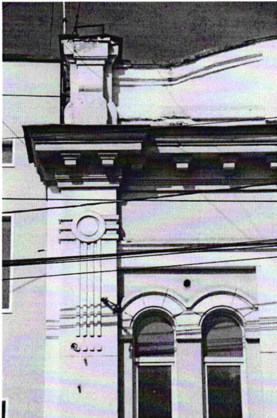
Видовая точка № 3 Фрагмент декора ризалита главного фасада
