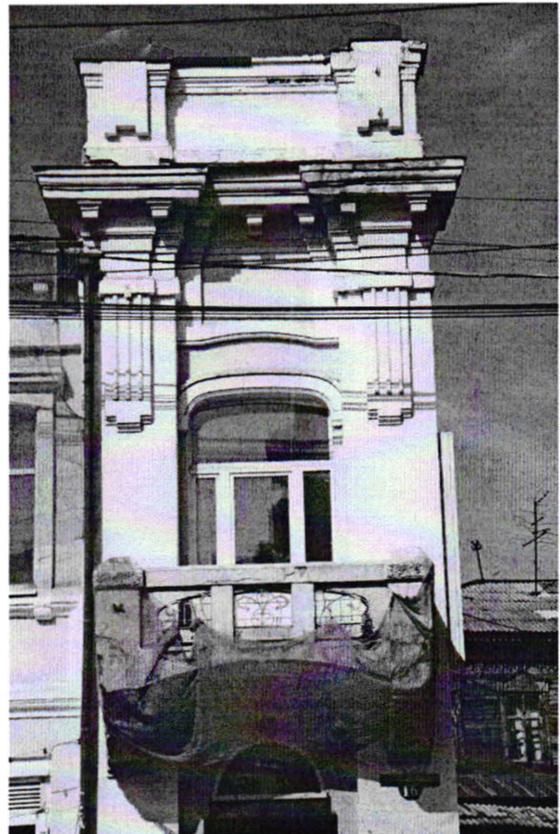
Видовая точка № 4 Фрагмент ризалита главного фасада с балконом
