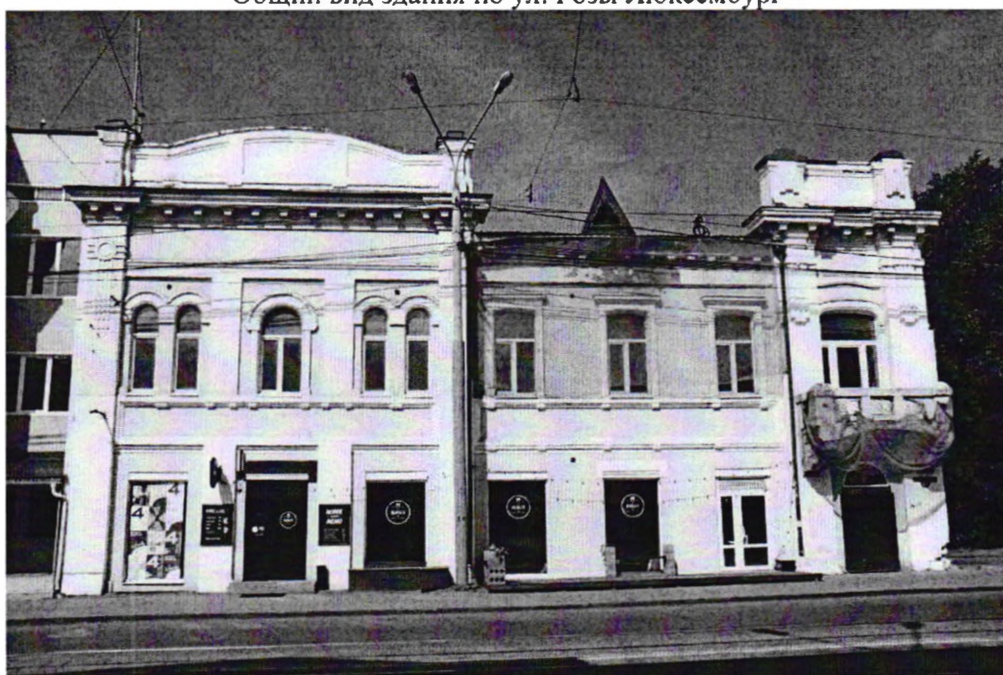
Видовая точка № 2 Главный (восточный) фасад здания
