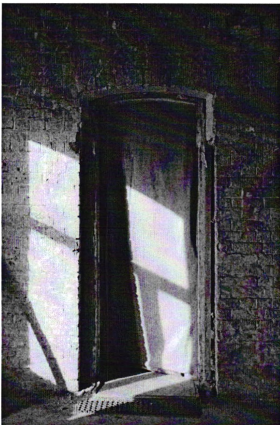
Видовая точка № 24 Лучковый дверной проем (Яблонская М.А., 27.09.2019)
