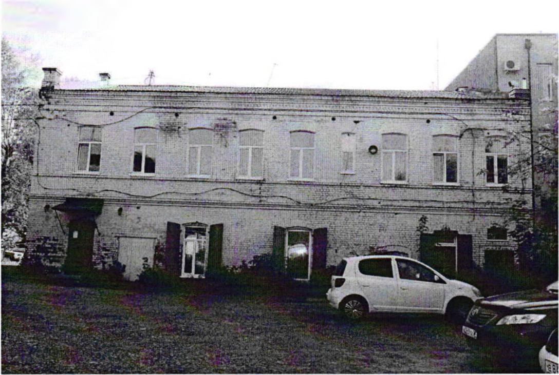
Видовая точка № 10 Западный (дворовый) фасад здания
